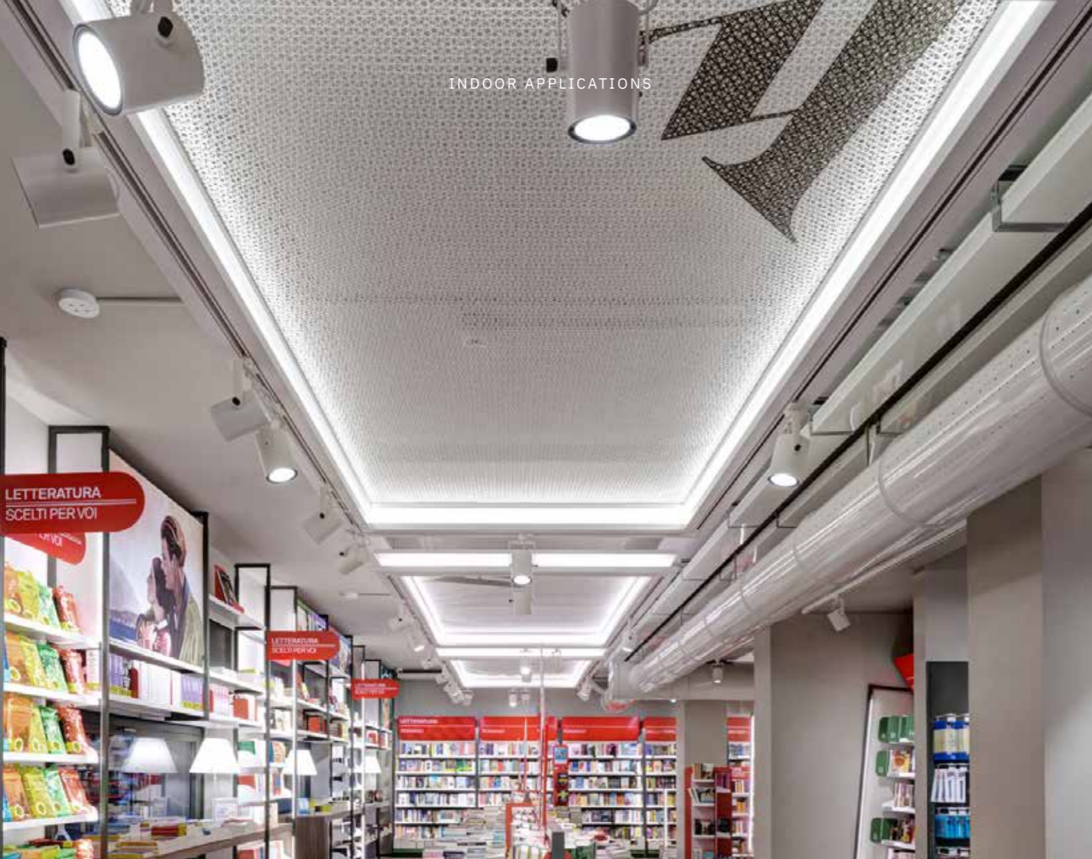
Ceiling as branding light diffuser Mondadori Store, Milano 2015, © Migliore+Servetto
